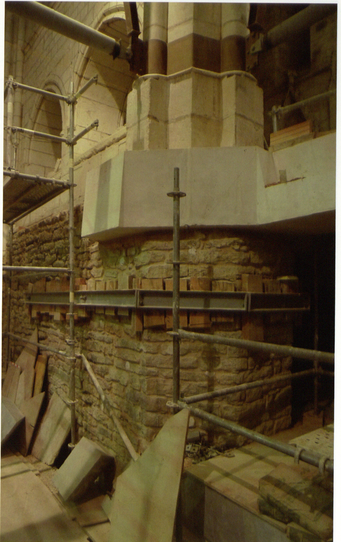
Los bloques de cantería que forman el atado de la cimentación se han podido preparar en taller gracias al exhaustivo trabajo de modelización digital de la estructura de la catedral. The stone blocks that make of the foundation binding were able to be readied in a workshop, thanks to the exhaustive digital modeling work on the cathedral's structure.
